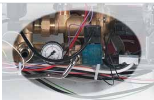
particolare riempimento automatico
