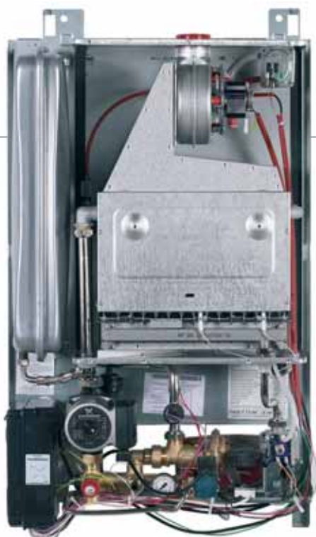
caldaia Spazio Tekno - vista interna
